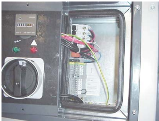
Klemmreihe in der Steuerung hinten dem rechten Bedienfeld
